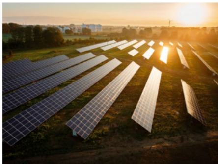
W Przejazdowie koło Gdańska znajduje się jedna z większych elektrowni słonecznych w Polsce. Może ona wytworzyć prąd dla ok. 700 domostw.
